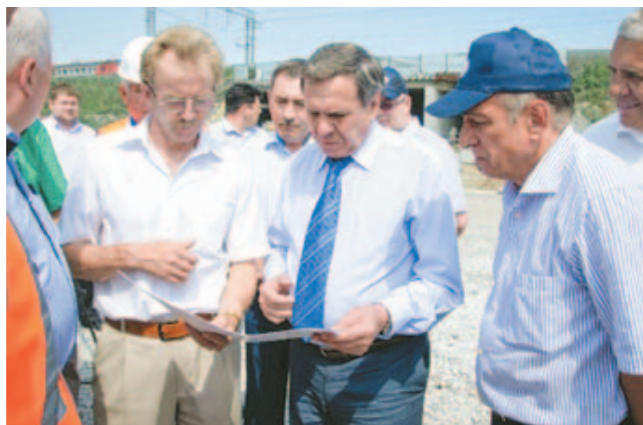
Губернатор Владимир ГОРОДЕЦКИЙ (в центре) и мэр р. п. Кольцова Николай КРАСНИКОВ (слева) на строительстве тоннеля
